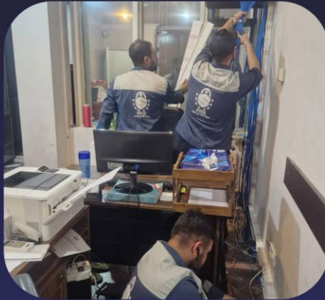
اجرای زیرساخت شبکه
